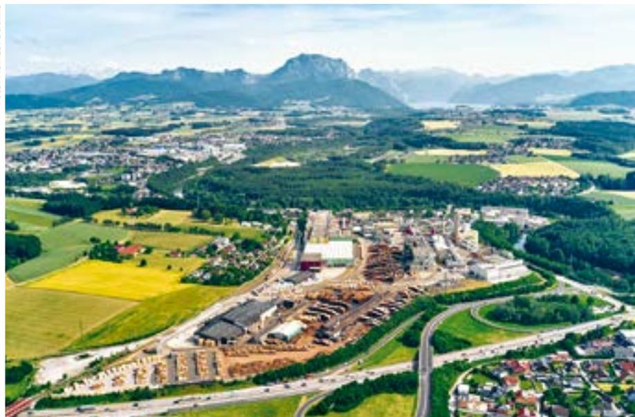
Die beiden Heinzel-Werke Steyrmühl (vorn) und Laakirchen (hinten) werden mit einer Dampfleitung verbunden und können in einem effizienten Energieverbund arbeiten.
