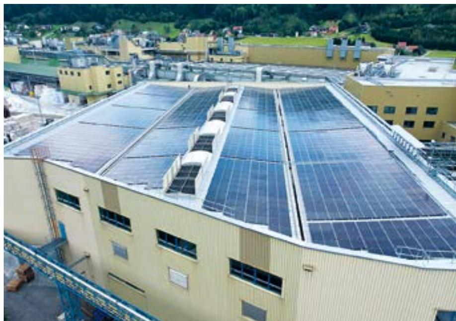
Die 2023 in Betrieb gegangene PV-Anlage in Frohnleiten liefert 3 MWh im Jahr, jetzt überlegt Mayr-Melnhof einen weiteren Ausbau.
